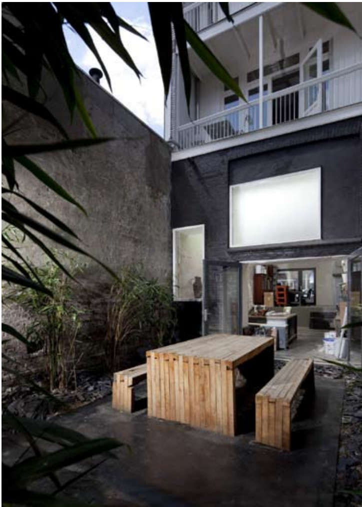
De Zwarte Parel, Rotterdam. Ontwerp: Rolf.fr. i.s.m. Zecc Architecten. Foto: Frank Hanswijk
